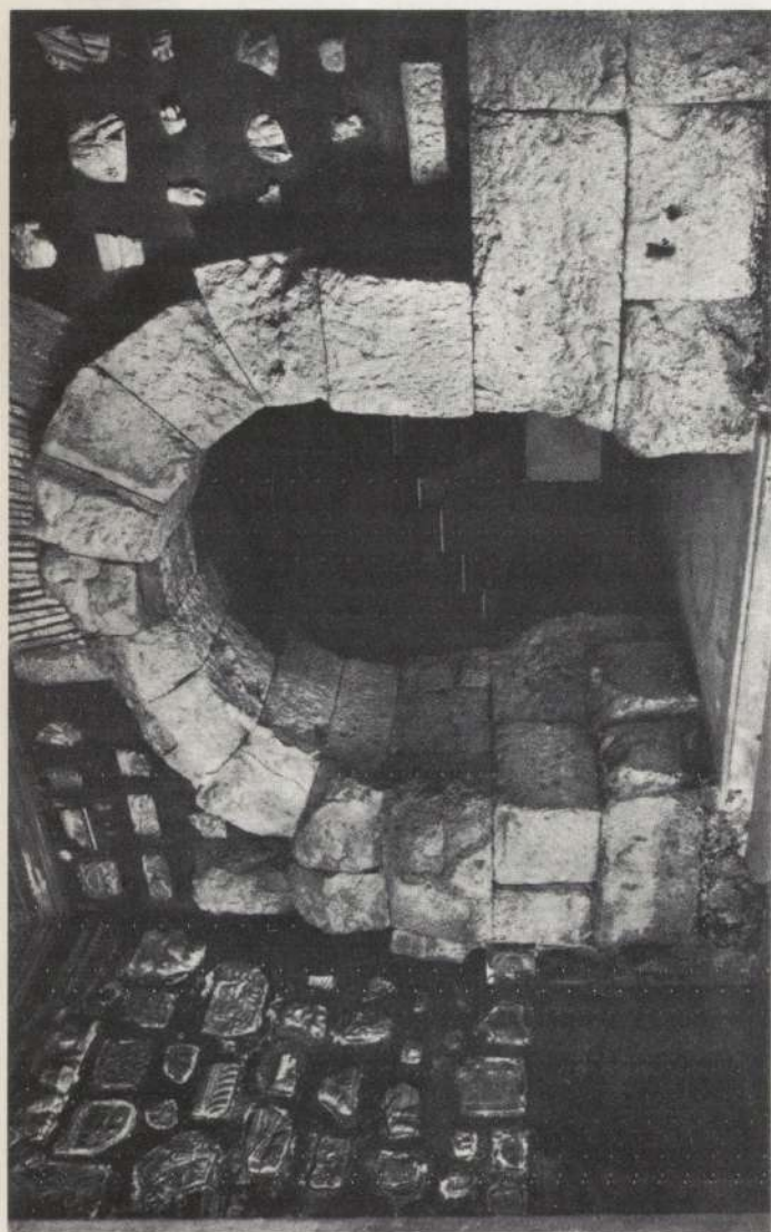
Arco di una camera balistica, forse per catapulte, nelle mura dette Serviane al Largo Magnanapoli (n. 158).
